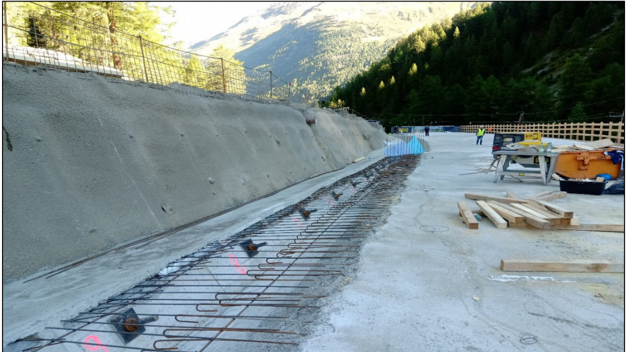
Bild 11: Spritzbetonnagelwand, Spannnischen - Verpressanker
